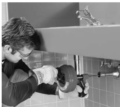
Figure 8 – Utilisation manuelle du Power-Spin
