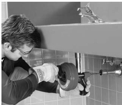
Figura 8 – Uso manual del Power-Spin
